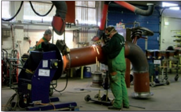
Zoveel mogelijk prefabricage om gezien de korte, beschikbare montagetijd zo weinig mogelijk bouwplaatsuren te gebruiken.
